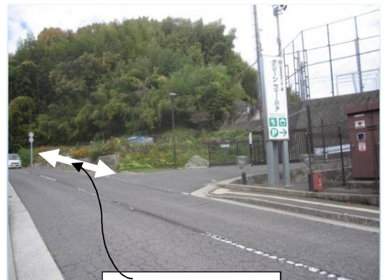
歩道未整備区間
